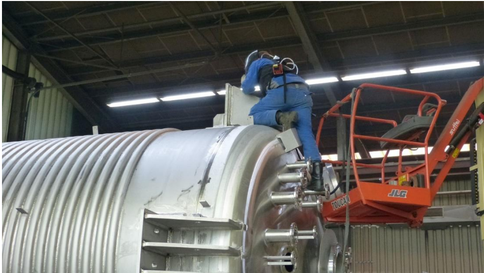
Abbildung 8: WIG-Schweißen an der Oberfläche eines Edelstahlbehälters
