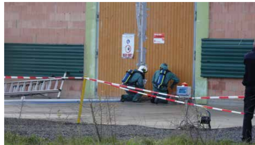
Mitarbeiter des holländischen Vertragsunternehmens in Schutzkleidung leiten das CO 2 -Gas in den gründlich abgedichteten Stall ein.
