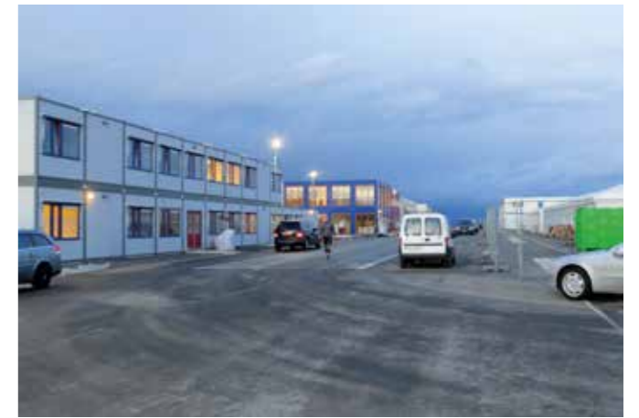
Was aussieht wie die Baustelle einer modernen Wohnsiedlung im Endstadium, das ist die (bei laufendem Betrieb) vollständig umgebaute Erstaufnahmeeinrichtung Calden. Asphaltierte Straßen, Wohncontainer, Sozialräume, ein Bereich für die medizinische Versorgung und eine großzügige Kantinenfläche bieten weit mehr als 1.000 Bewohnern mehr als nur eine Unterkunft. Foto: RP
