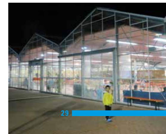
Unter dem Glasdach der Erstaufnahme in Lohfelden waren auch bei schlechtem Wetter viele Aktivitäten möglich. Die Nachteile: Im Winter froren Leitungen ein, im Sommer gab es Fehlalarme aufgrund der Hitzeentwicklung.
