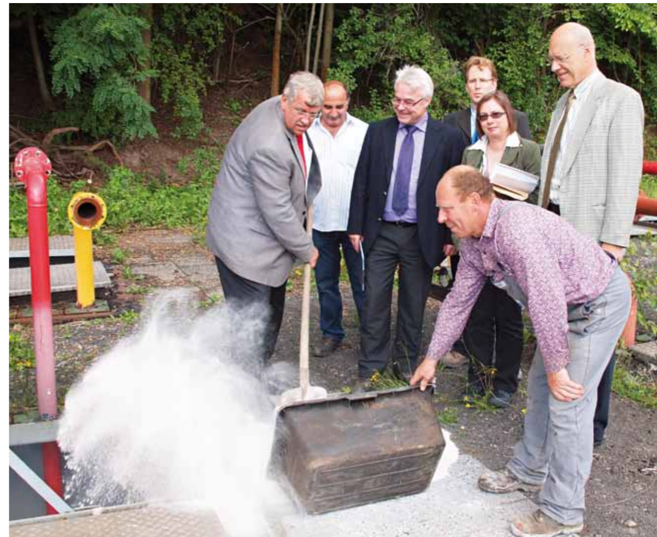
Mit der letzten Schippe Granulat beendet Regierungspräsident Dr. Walter Lübcke offiziell die Sicherungsarbeiten am ehemaligen LOMO-Tanklager in Bad Hersfeld. Im Vordergrund unterstützt ihn Ingo Hartwig. Mit ihnen freuen sich über die gelungene Zusammenarbeit Dr. Mansour Dlikan vom ausführenden Bauunternehmen, Dezernatsleiter Klaus Palm und seine Mitarbeiterin Ute Zier, Jürgen Braatz vom beteiligten Planungsbüro und Abteilungsleiter Ernst Bergbauer. Foto: Gerhard Manns
