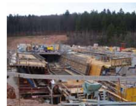
Bau der Steinbachtalbrücke bei Föhren im Taktchiebeverfahren
