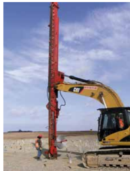
Wie mit einer Nähnadel setzt der Bagger die vertikale Drainage in den Untergrund der künftigen Start- und Landebahn. Foto: Bernd Lehmann
