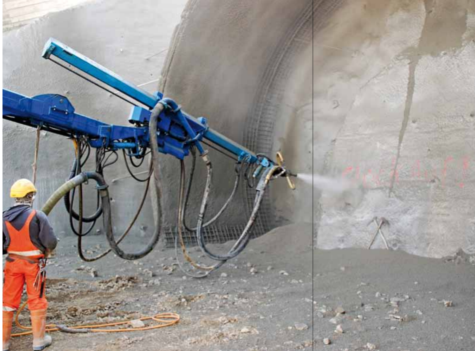
Sicherung des Tunnels bei Hessisch Lichtenau durch ein Gewölbe aus Spritzbeton
