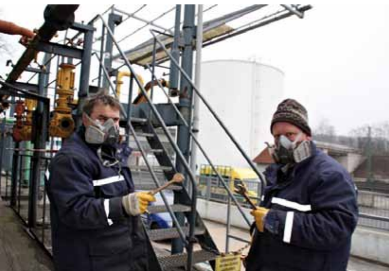
Arbeiten mit Atemschutz bei der vorausgegangenen Sicherung des alten Tanklagers: Thomas Lax und Ingo Hartwig. Foto: RP
