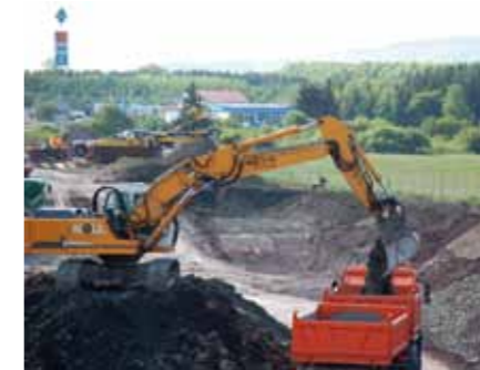
Abtransport der Erdmassen aus dem Schulbergtunnel der A 44
