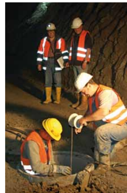
Grundwasserarbeiten im Schulbergtunnel
